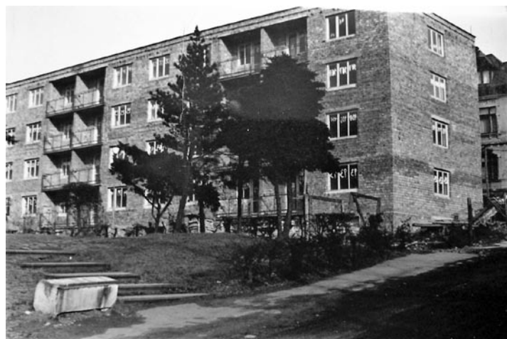
Takto se například stavěl dům ve Wolkerově ulici čp. 90, 91 a 92 v Děčíně II
