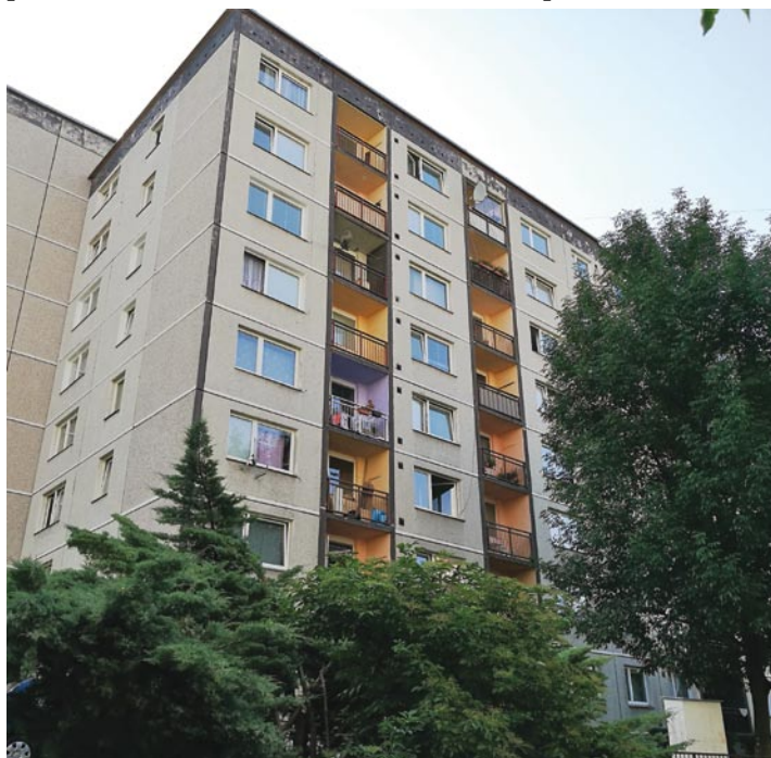
Dům samosprávy 321 v ul. Čsl. Partyzánů č.p. 379 v Boleticích nad Labem je před rozsáhlou rekonstrukcí, která by měla odstranit i všechny závady, za které vlastníků bytů Magistrát pokuty uložil.
