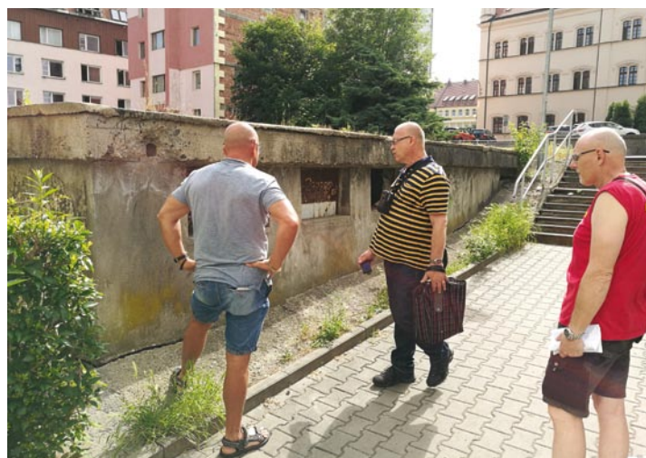
Odborný statik Ing. Roman Cupal (v pruhovaném triku) na prohlídce obvodového pláště garáží. Vlevo Ing. Gustav Behina, vedoucí technického oddělení SBD Děčín, vpravo člen výboru samosprávy 263 pan Vladimír Stehlík.
