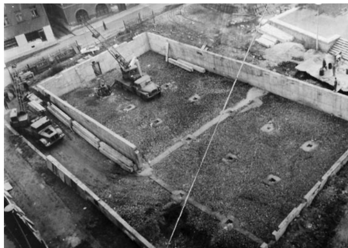
Tento vzácný snímek z archivu pana Vladimíra Lipského pochází z jara 1970, kdy se stavbou podzemních garáží započalo. Téměř padesátiletá stavba svépomocí generálku nutně potřebuje.
